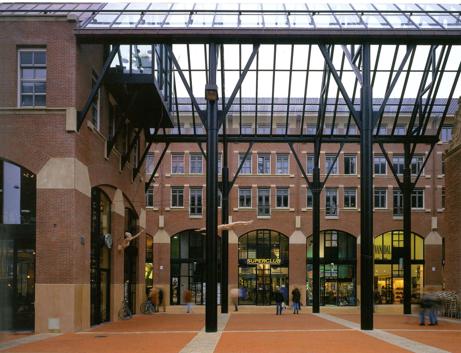
Galerij tussen Waagstraat en binnenplein Gallery between Waagstraat and courtyard
